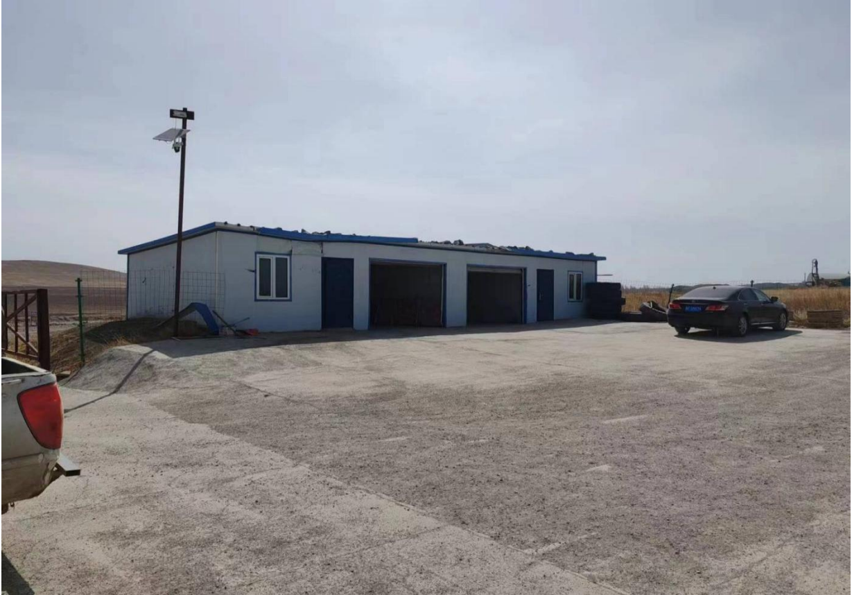
照片9 修理车间
